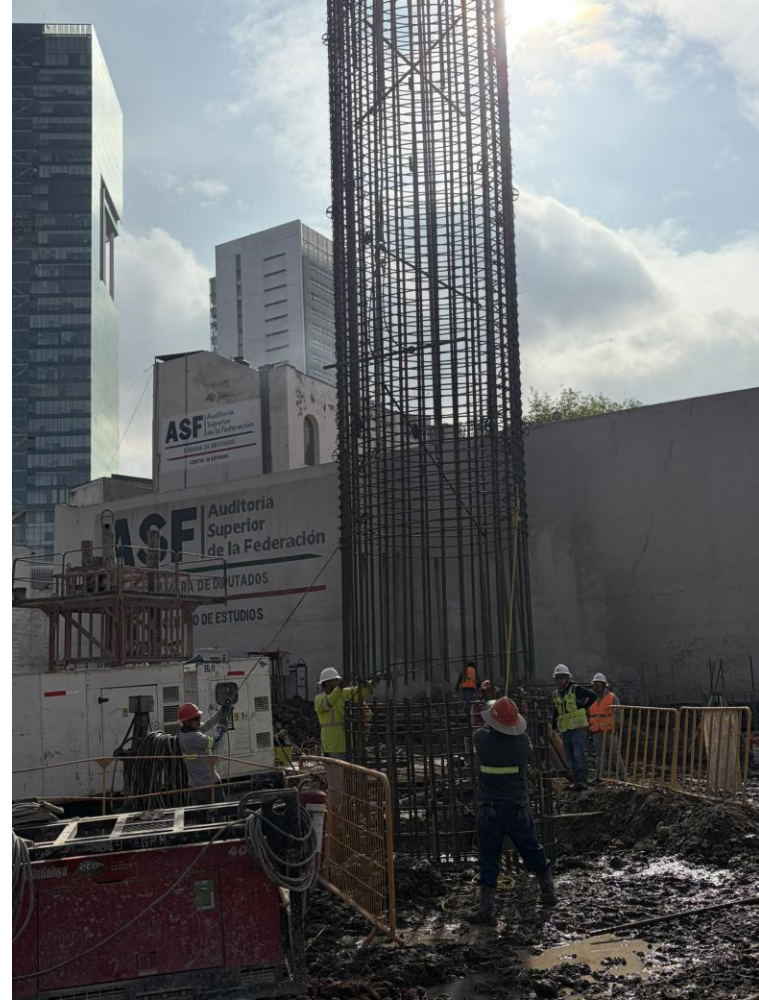
Refuerzo y colocación de la pila
