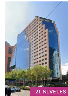
5. Av. Paseo de la Reforma N° 1
