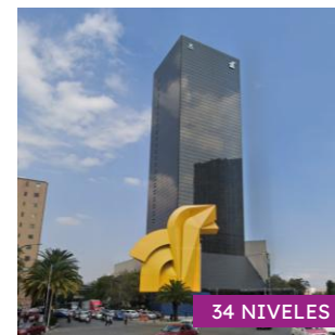
7. Av. Paseo de la Reforma N° 10.
