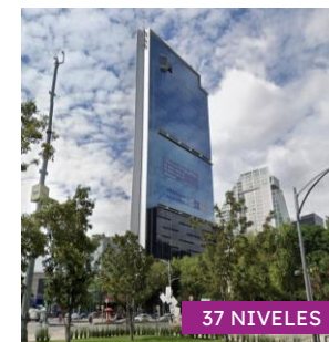
8. Av. Paseo de la Reforma N° 180.
