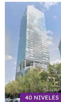
6. Av. Paseo de la Reforma N° 26
